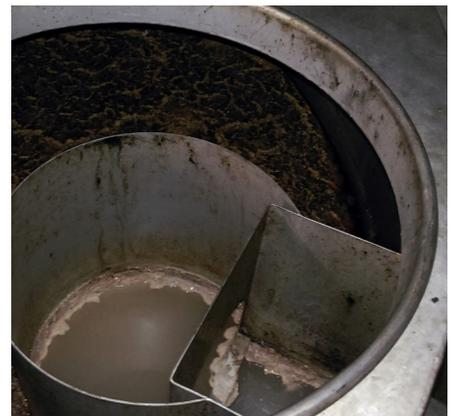
Der Inhalt des Fettabscheiders ist vollständig abzusaugen und anschliessend zu reinigen und mit Wasser wiederaufzufüllen. Das Reinigungsintervall ist dabei auf die Belastung des Fettabscheiders abzustimmen. Gemäss SN EN 1825-2 sind Fettabscheider monatlich zu entleeren und zu reinigen. Die Praxis zeigt, dass ein Intervall von drei Monaten in vielen Fällen sinnvoll ist. Zudem ist der Fettabscheider alle 5 Jahre einer Inspektion durch den Hersteller zu unterziehen.
