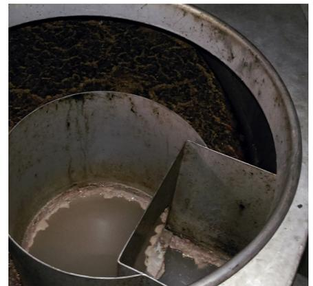
Le contenu du séparateur de graisses doit être entièrement vidé. Le séparateur doit ensuite être nettoyé puis à nouveau rempli avec de l'eau. La fréquence de nettoyage dépend de l'encrassement du séparateur de graisses. Selon la norme SN EN 1825-2, les séparateurs de graisses doivent être vidangés et nettoyés une fois par mois. Dans la pratique, un intervalle de 3 mois est le plus souvent sensé. En outre, le constructeur doit procéder à une inspection du séparateur de graisses tous les 5 ans.
